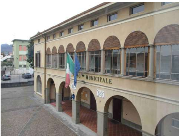
Prospetti ovest e sud dove si possono osservare i frangisole in legno che verranno smontati
