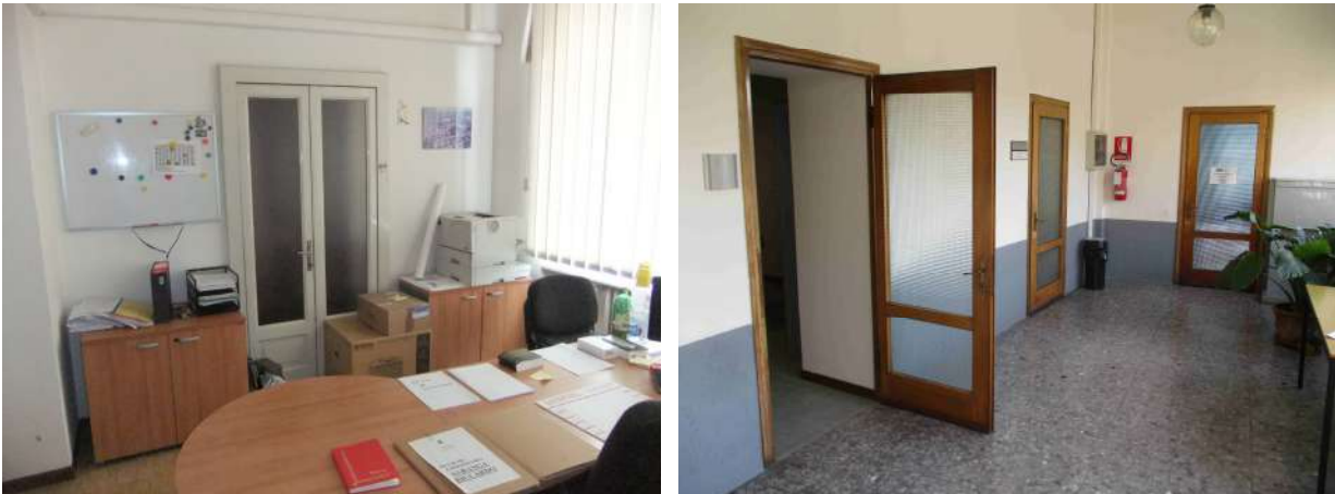
Porte interne esistenti
