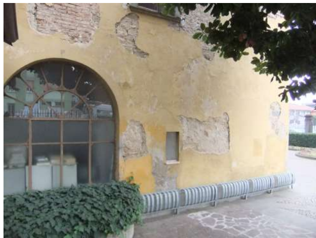
Scrostamento degrado degli intonaci esterni
