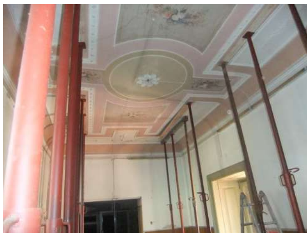
Soffitto in arelle intonacate decorato zona ex poste
