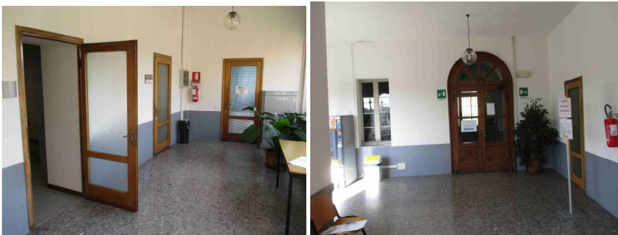
Pavimentazione presente al piano primo
