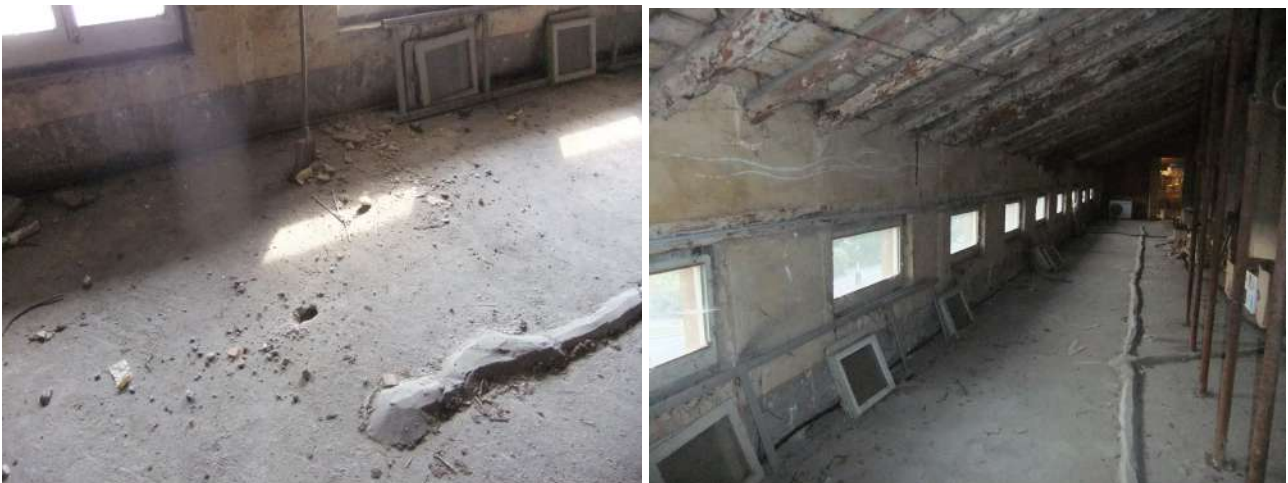
Solai in laterocemento al piano sottotetto
