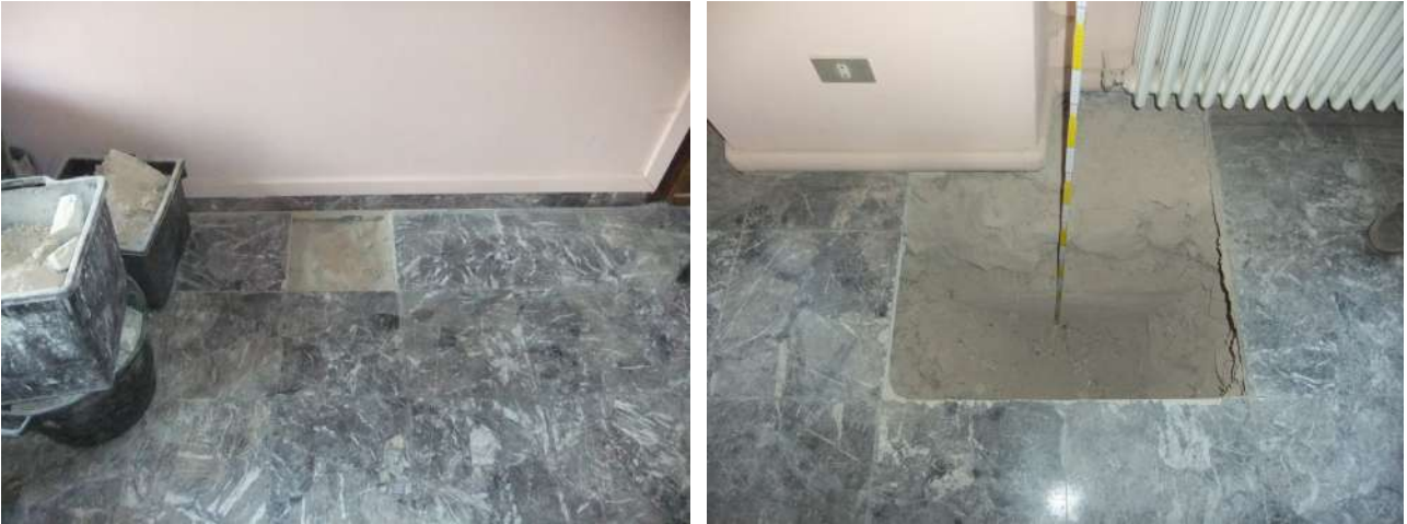
Saggi conoscitivi realizzati nella pavimentazione al di sopra della volta.
