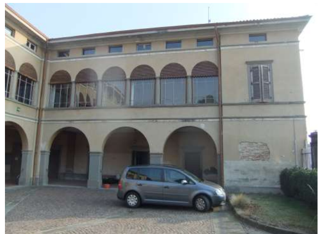
Prospetti ovest e sud dove si possono osservare i frangisole in legno che verranno smontati
