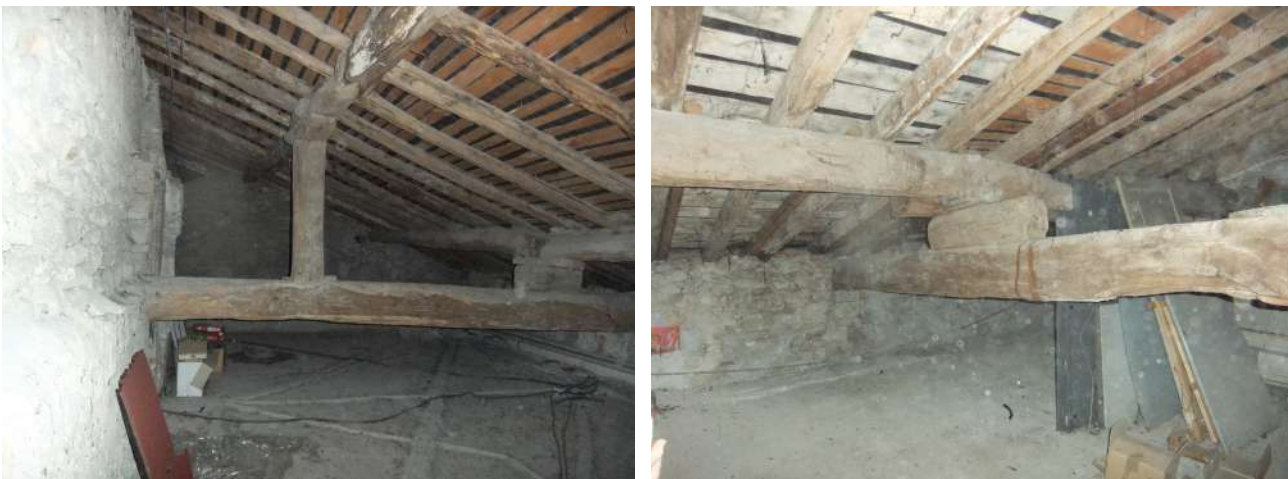
Orditura in legno della copertura
