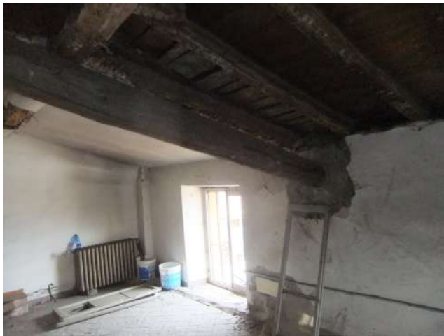
Porzione di copertura danneggiata
