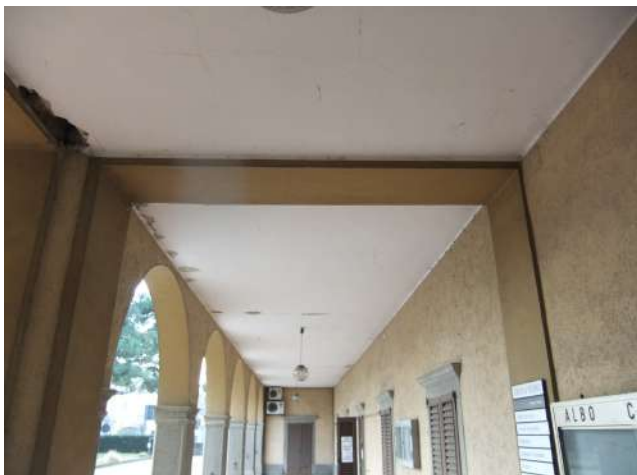
Soffitto in arelle intonacate portico piano terra
