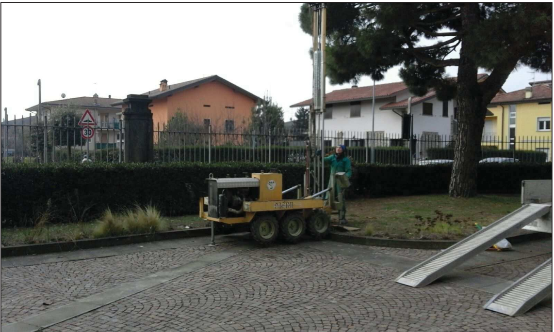
Figura 4 - Esecuzione delle prove penetrometriche dinamiche.
